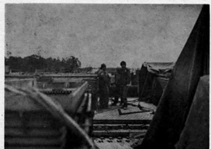
Монтажа цевног система на ТЕНТ-у — „Б“
